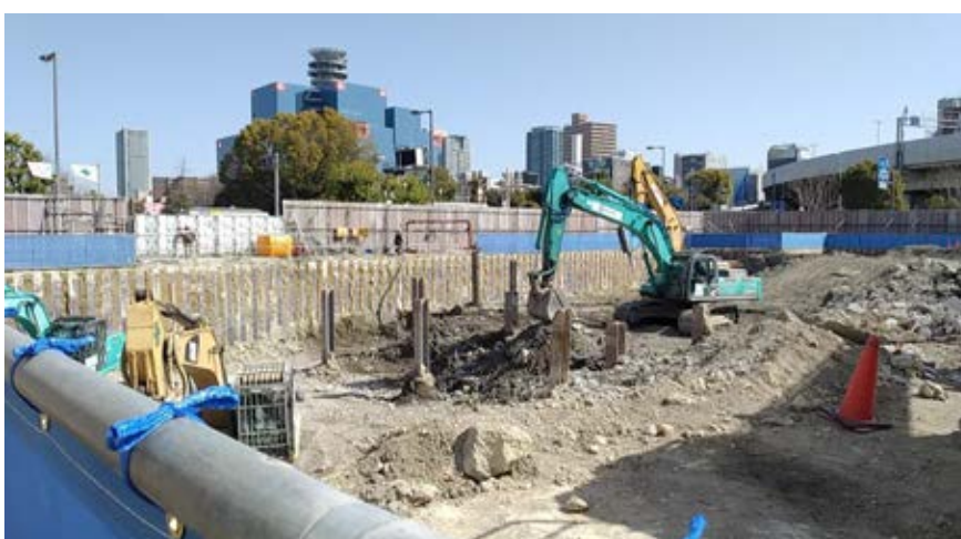
⑤2021年3月18日（木） 地上写真 北棟北西 北西工区掘削・水道局解体
