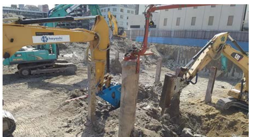
⑧2021年3月18日（木） 地上写真 北棟 水道局基礎解体
