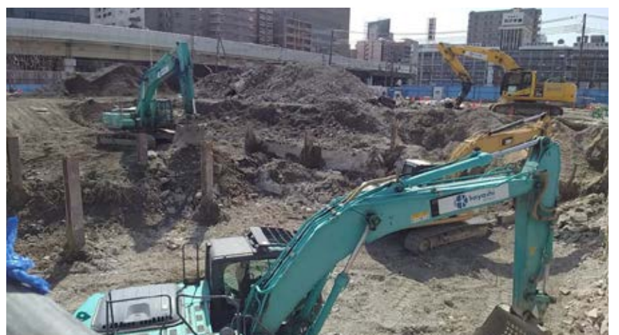
④2021年3月18日（木） 地上写真 北棟北西 北西工区掘削・水道局解体
