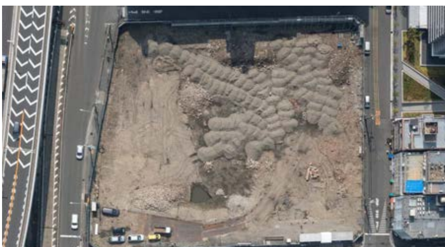
③2021年3月15日（月） 空撮写真 南棟（写真上が南）
