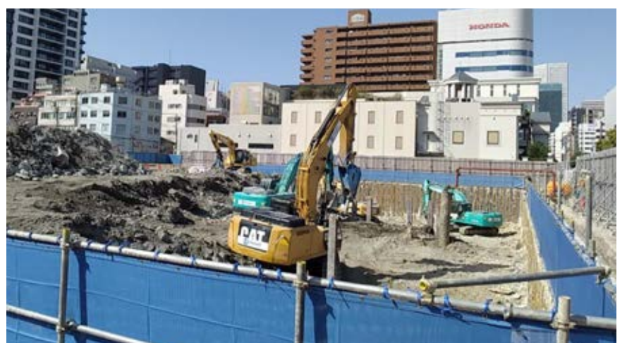
⑥2021年3月18日（木） 地上写真 北棟北東 北西工区掘削・水道局解体
