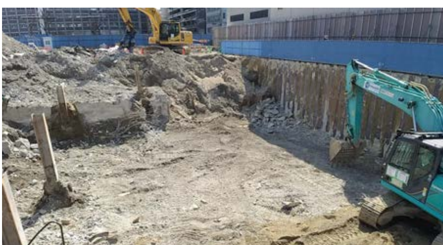
⑦2021年3月18日（木） 地上写真 北棟 北西部基礎解体完了
